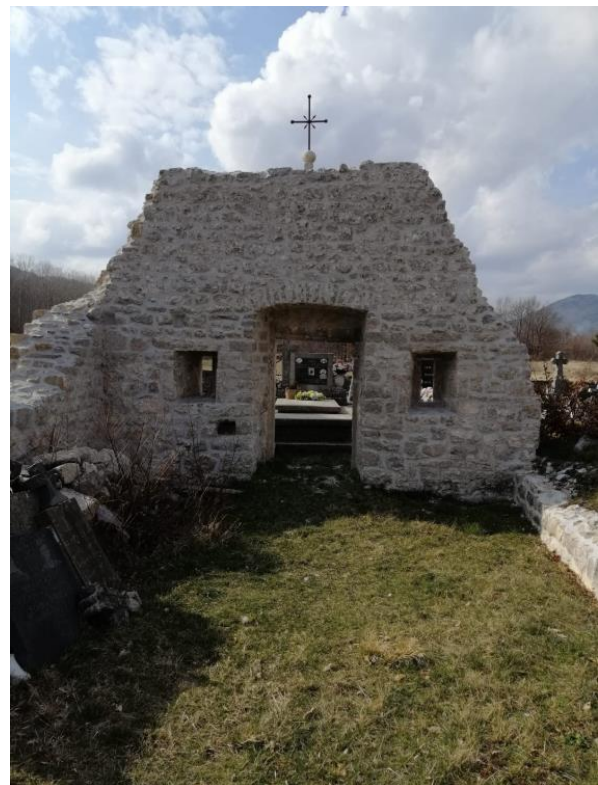
Slika 24. Unutarnje lice zapadnog pročelja – pogled prema zapadu (Foto: Marko Kojundžić)
