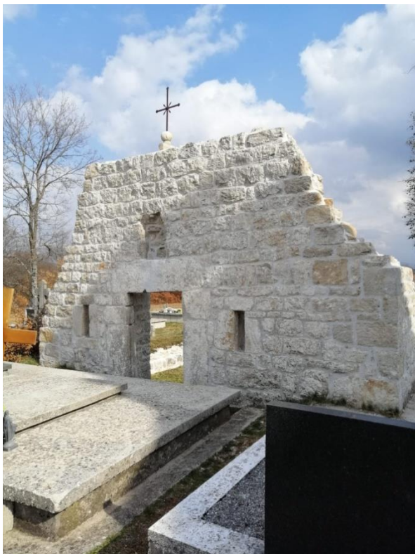
Slika 23. Ostaci zapadnog pročelja – pogled prema sjeveroistoku (Foto: Marko Kojundžić)
