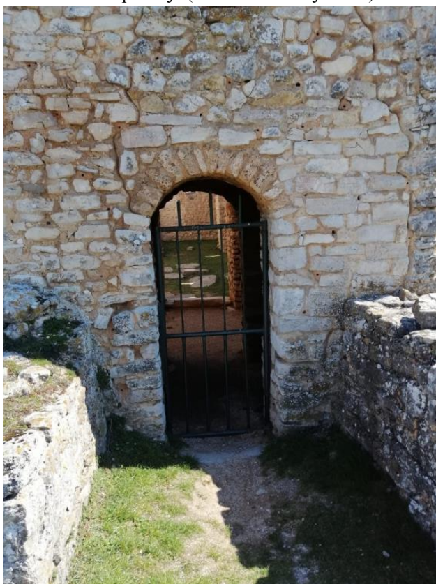
Slika 63. Ulaz na zapadnom pročelju (Foto: Marko Kojundžić)
