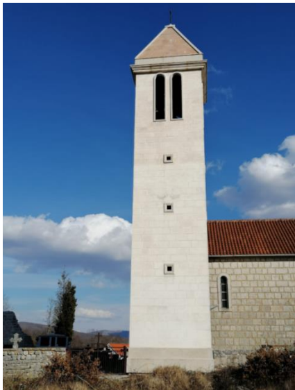
Slika 22. Vanjski izgled zvonika (Foto: Marko Kojundžić)
