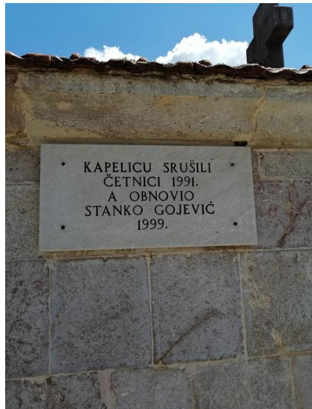
Slika 79. Ploča s natpisom o rušenju i obnovi kapele (Foto: Marko Kojundžić)
