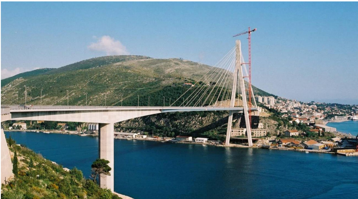
Slika 7.41 – Most preko rijeke Dubrovačke (slika pred dovršenje)
