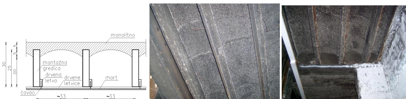
Slika 6.37 – Sustav Isteg, poprečni presjek i izgled
