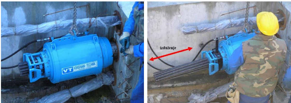
Slika 7.22 – Dvorana Višnjik – prednapinjanje temeljnog prstena [16]
