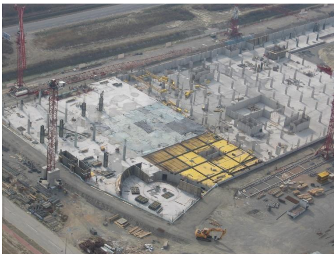
Slika 6.103 – Temeljna ploča trgovačkog centra Portanova, Osijek: a) fotografija objekta u gradnji, b) presjek kroz dio građevine
