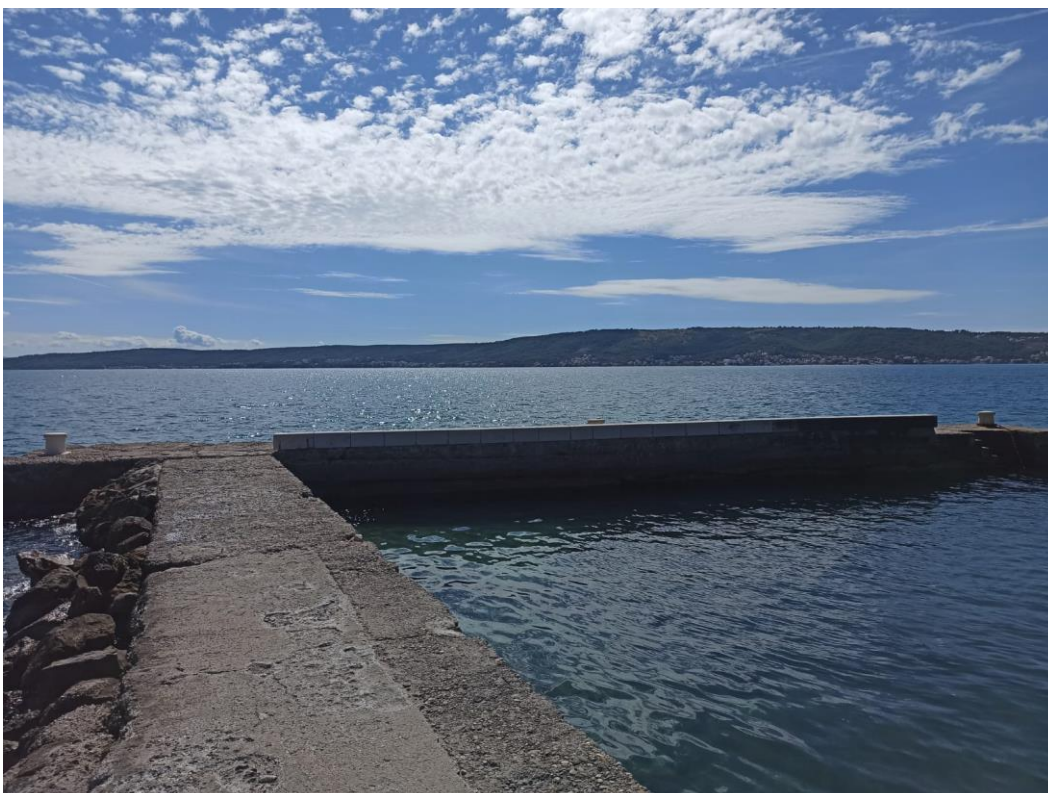
Slika 1.4 Prilaz južnom lukobranu
