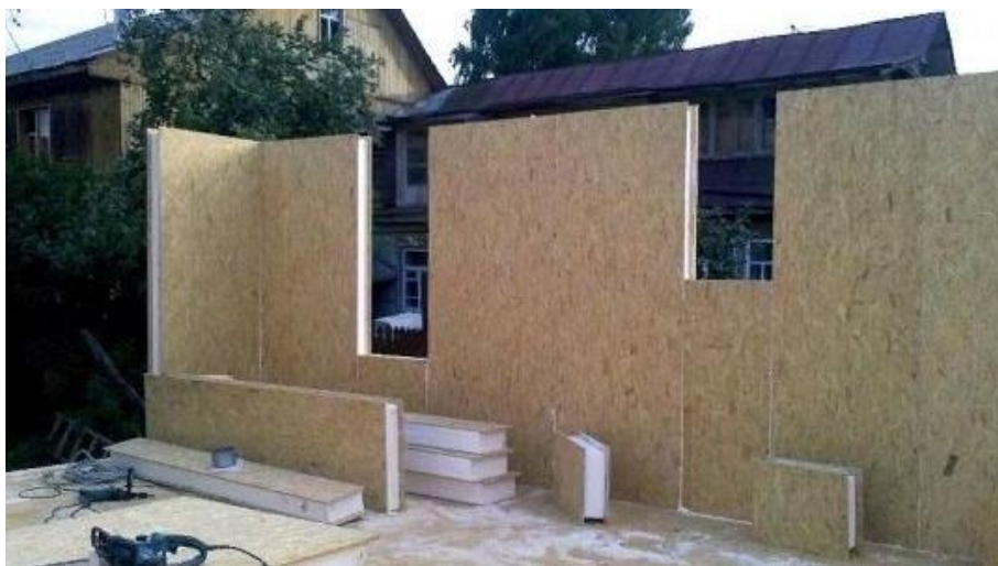
Slika 10. Gradnja objekta sa SIP pločama
