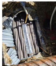
Slika 6. Mjerni senzori na betonu i prednapetom čeliku
