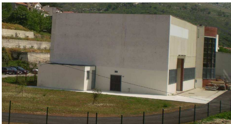
Slika 2.11 Zgrada Laboratorija za potresna ispitivanja u Žrnovnici
