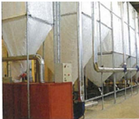
Slika 11. Silosi za stabilizaciju granula stiropora 14
