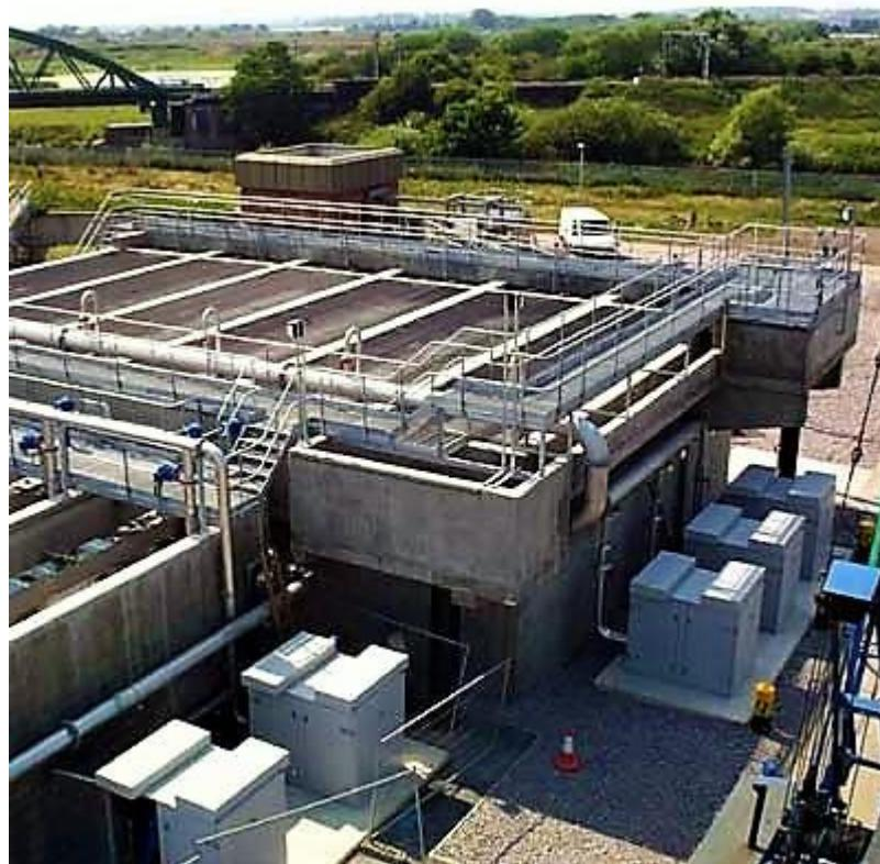
Slika 3.1 – Prikaz pogona za brzu pješčanu filtraciju [6]
