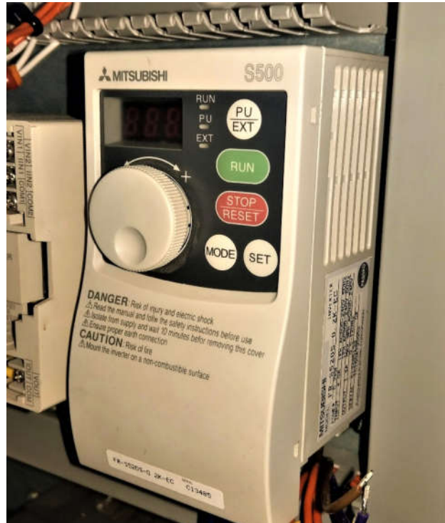
Slika 5.3. Frekvencijski pretvarač Mitsubishi S500 FR-S520S-0.2K
