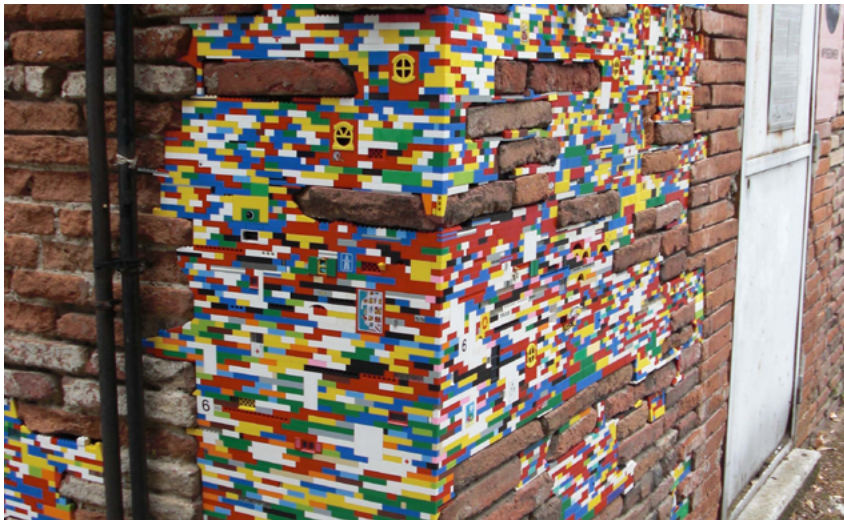
Slika 7. Dispatchwork – Popravljanje pukotina s Lego kockicama
