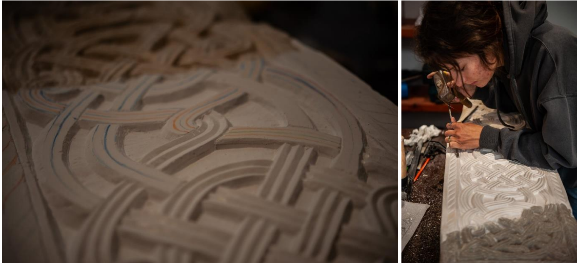
Slika 69 i Slika 70 Klesanje ornamenta na Acrytalnoj rekonstrukciji (autor: Rina Dubravec i Zoran Boban)
