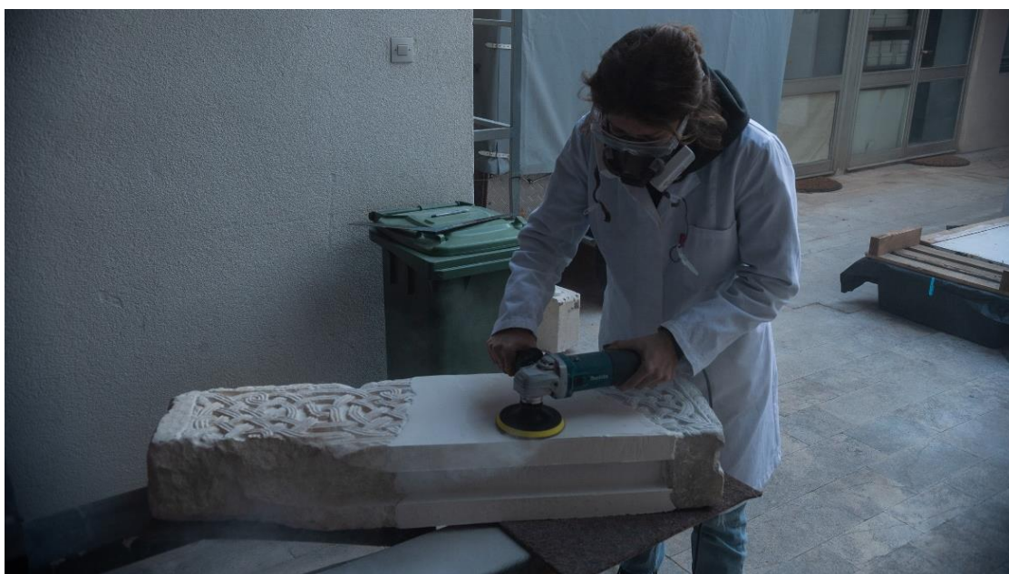
Slika 66 Ravnanje površine Acrystala brusilicom (autor: Zoran Boban)
