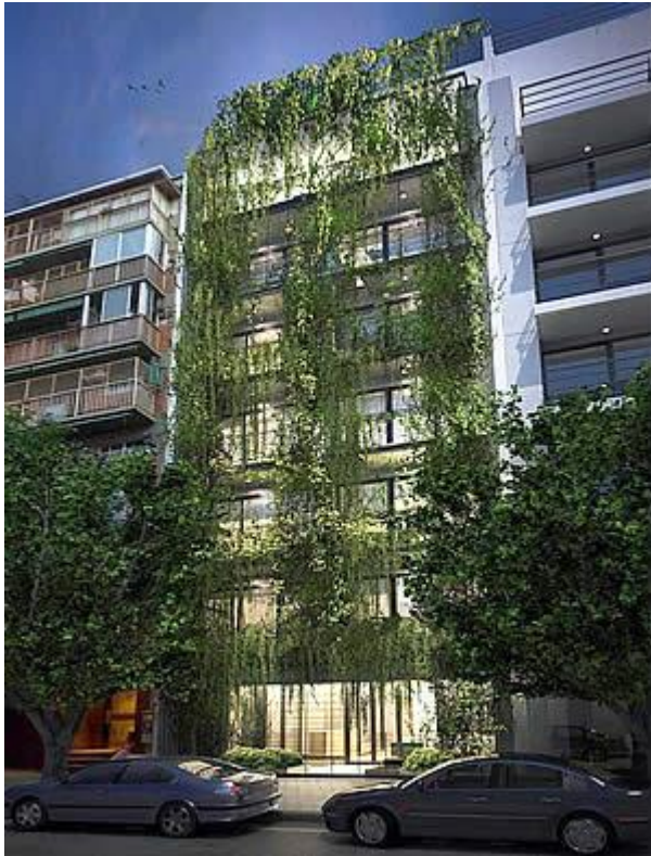
Slika 26. Vanjski izgled hotela Palo Santo
