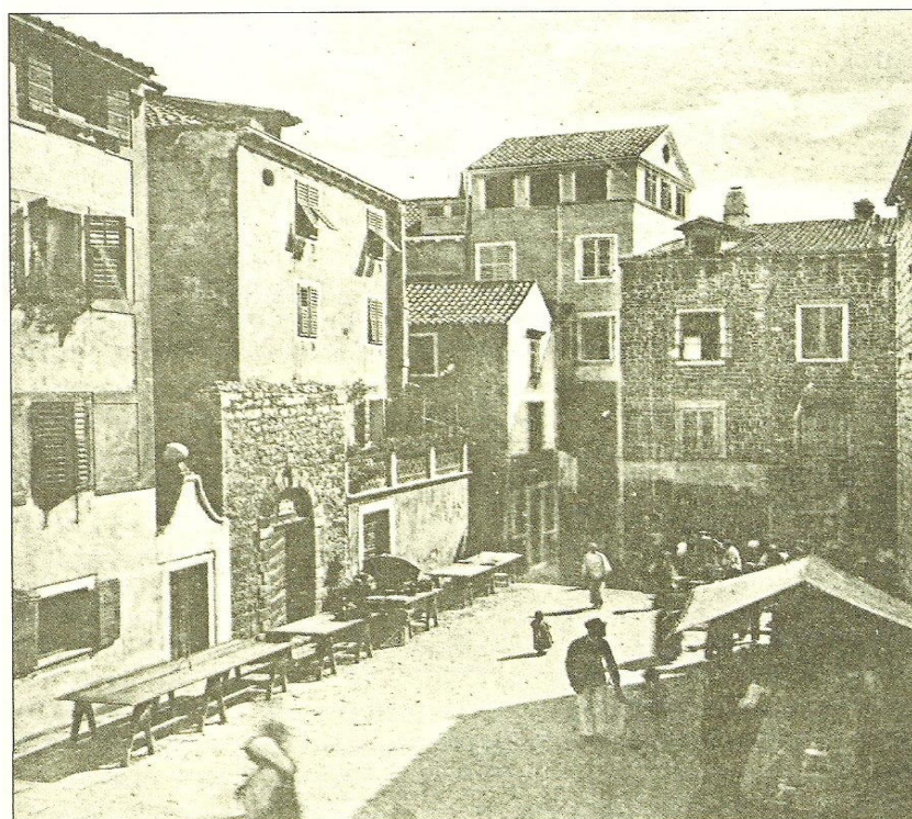
Slika 4. Pogled na Malu Ložu (trg Ivana Pavla II.)
