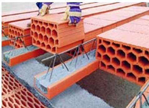
Slika 6.45 – Sustav Fert – Postavljanje ispuna na gredice
