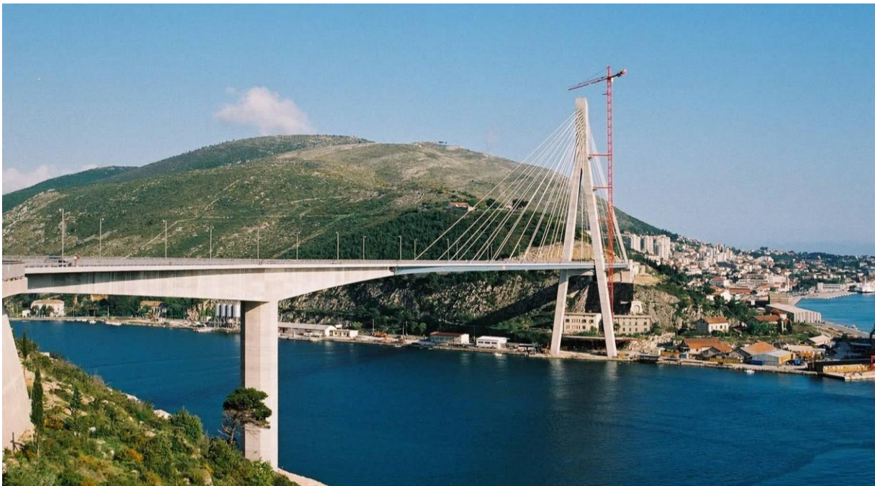
Slika 7.41 – Most preko rijeke Dubrovačke (slika pred dovršenje)
