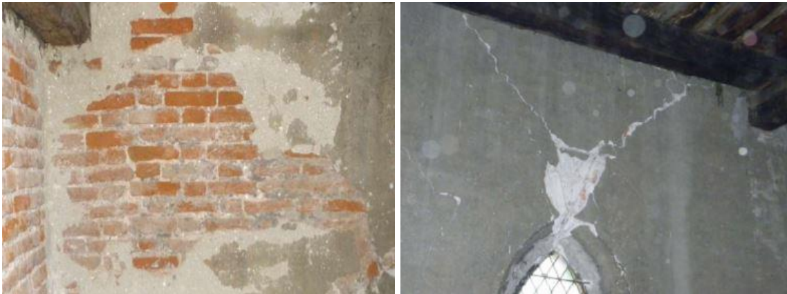
Slika 2.5. Prikaz zidova zvonika: a) Karakteristično zide s vidljivim načinom gradnje; b) Unutarnja obrada zida s prisutnim oštećenjem [2].
