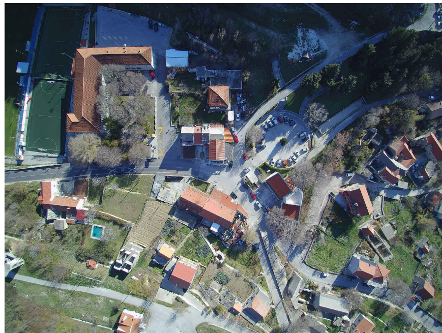
slika br. 68 - fotografija postojećeg stanja
