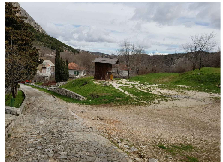
slika br. 75 - fotografija postojećeg stanja
