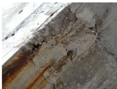
Slika 2.2. Oštećenja stupova na krčkom mostu uslijed korozije [2]
