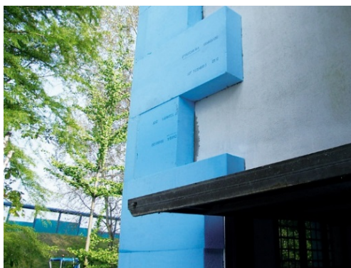
Slika 14. Fasadni ETICS sustav s XPS-om, [2].
