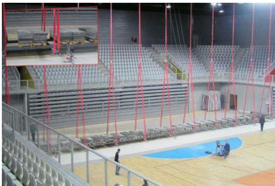
Fotografija 1.1: Statičko ispitivanje rešetkaste konstrukcije sportske dvorane
