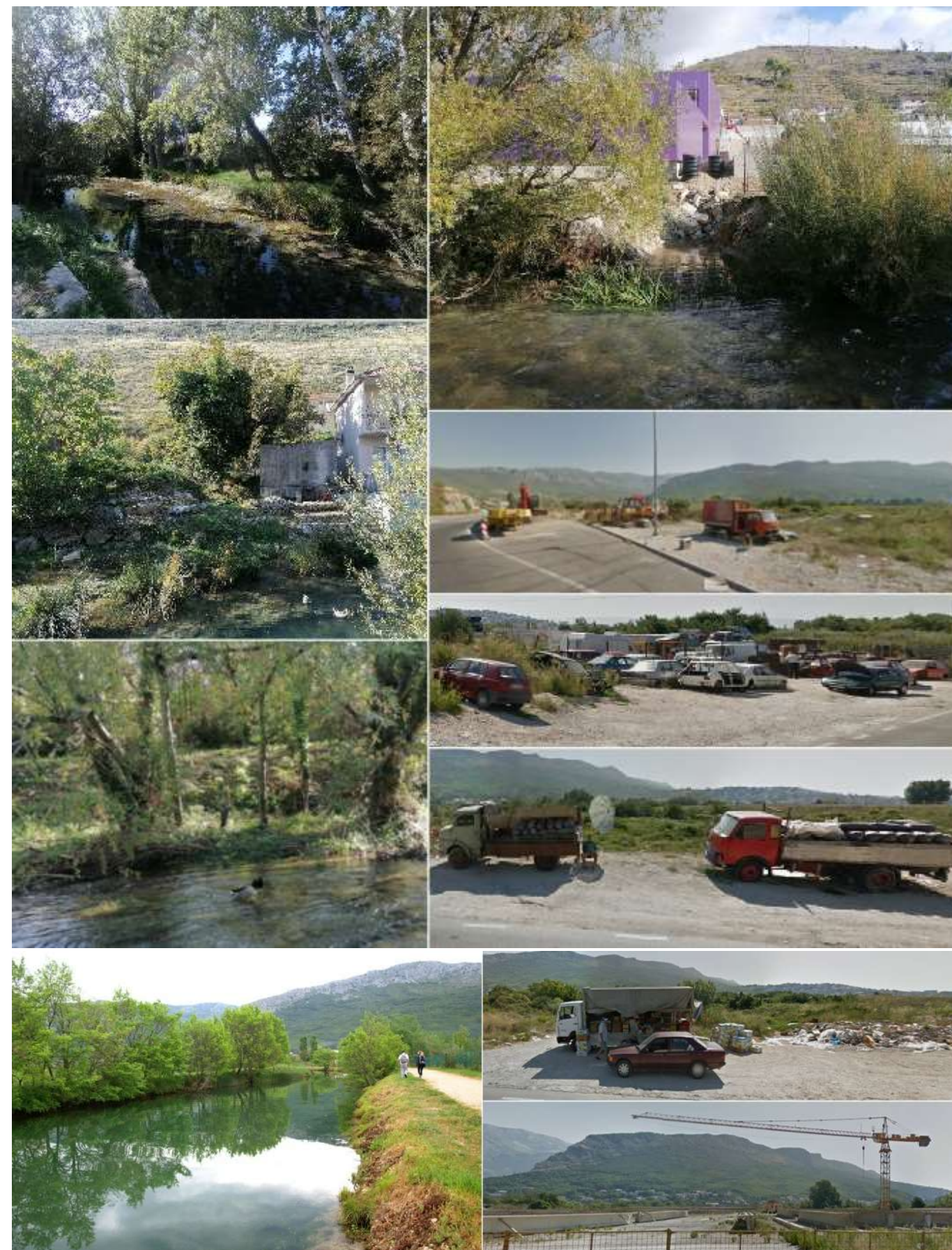
Kontrastne situacije zatečene na lokaciji
