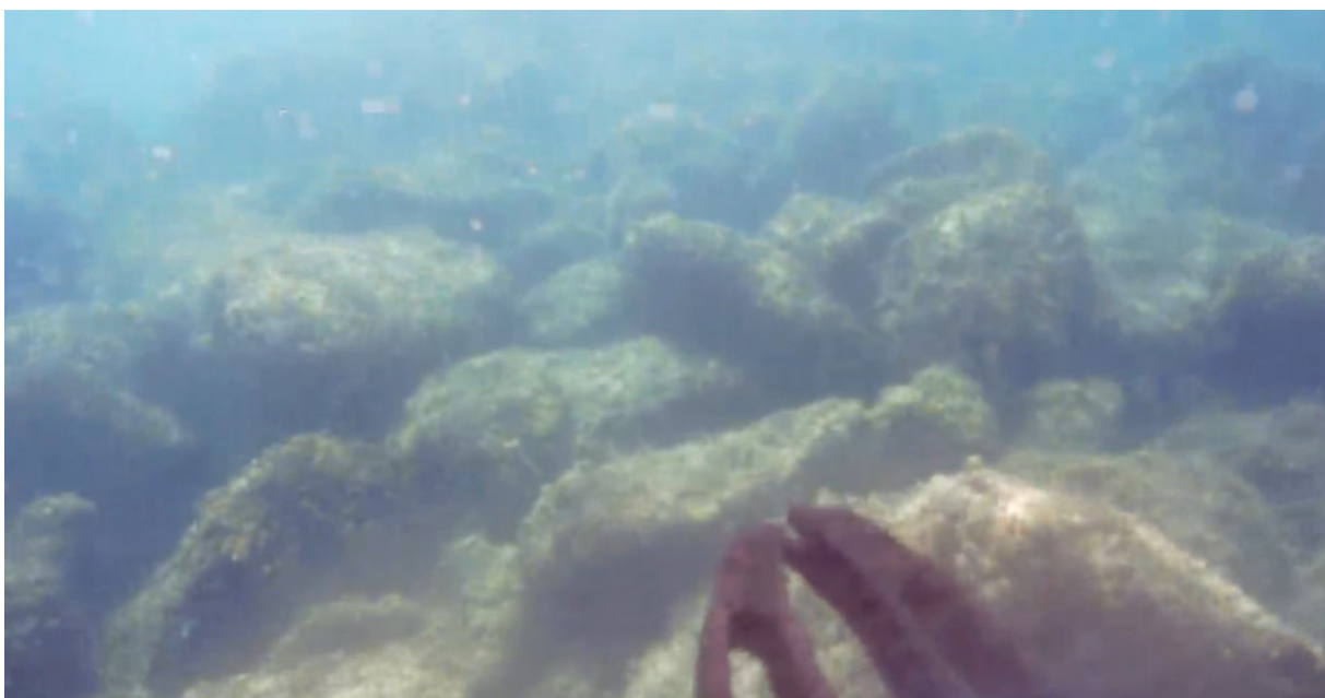
Slika 8.1.2. Podvodna fotografija postojećeg lukobrana napravljena bespilotnom ronilicom
