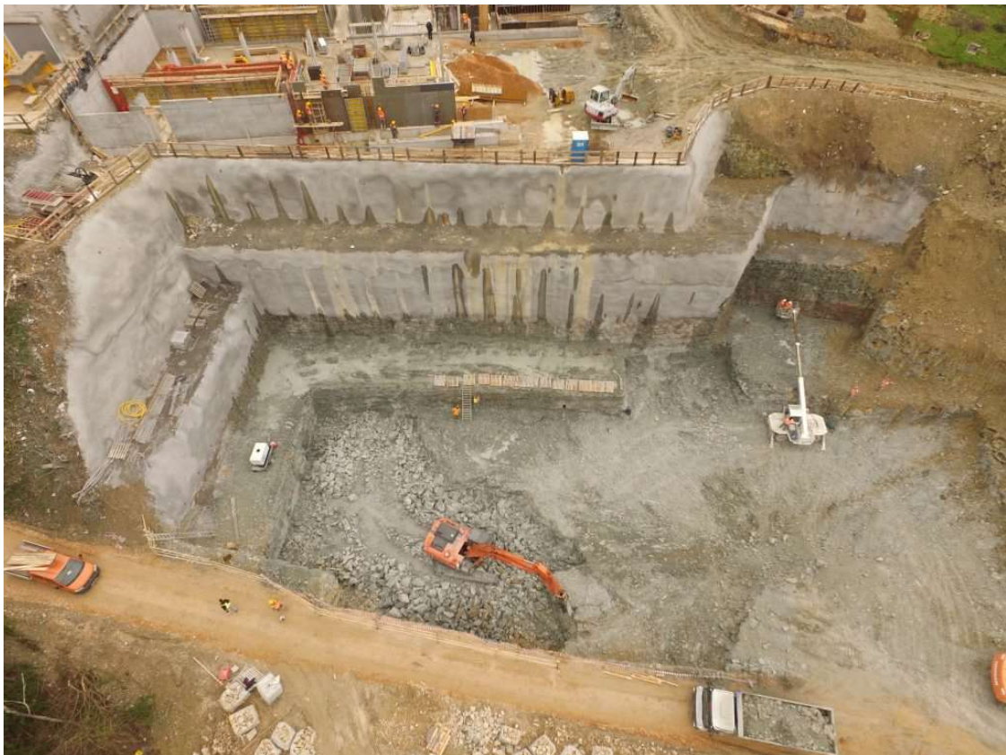
Slika 2. Primjer građevne jame
