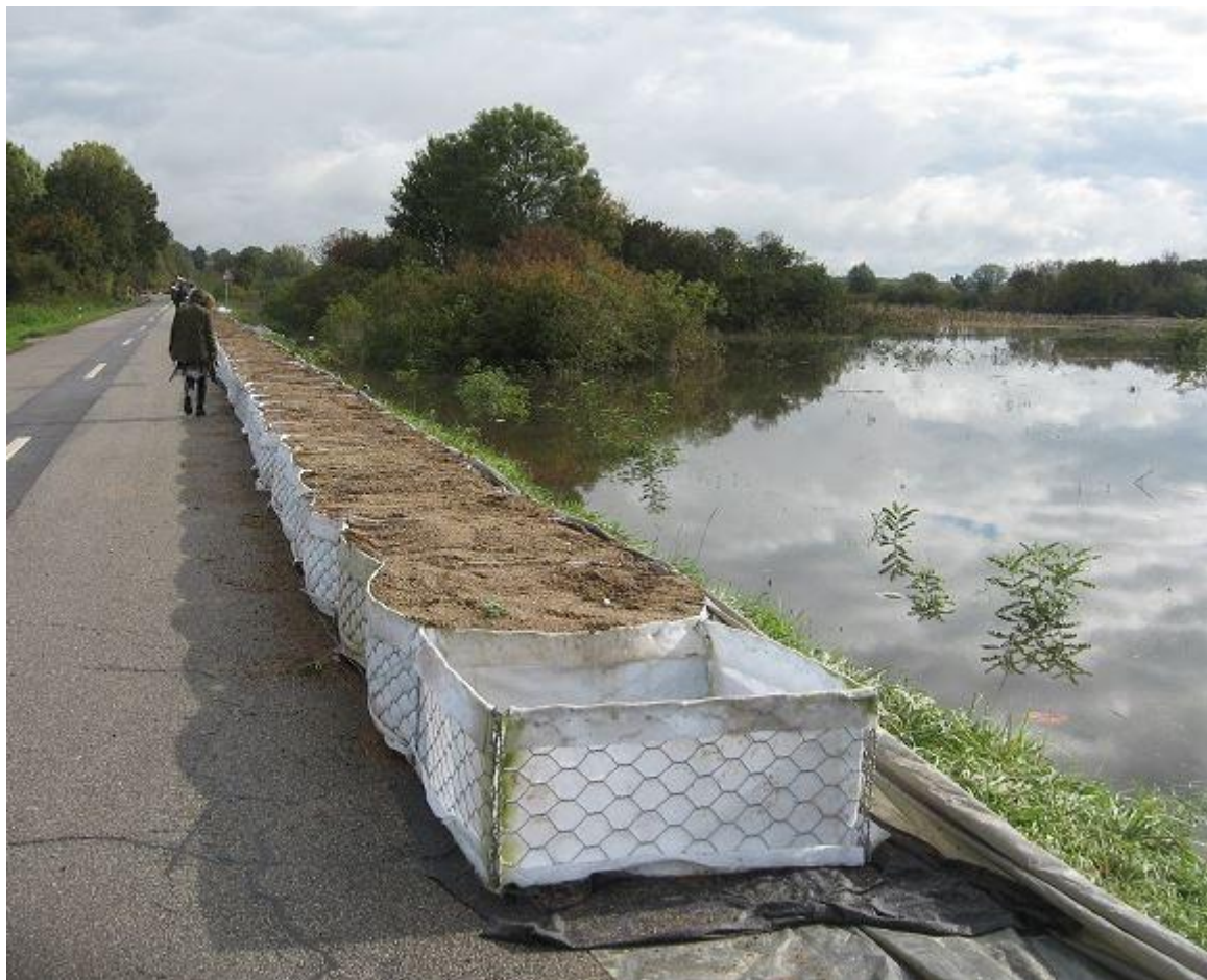
Slika 2. Prikaz stanja prometnice za vrijeme poplave
