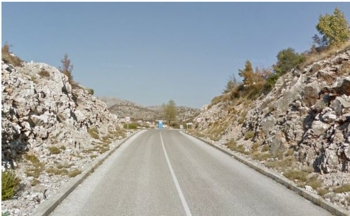
Slika 1. Prikaz postojećeg stanja prometnice OS 1
