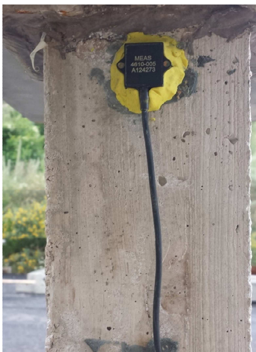
(a) Mjerenje ubrzanja na stupu
