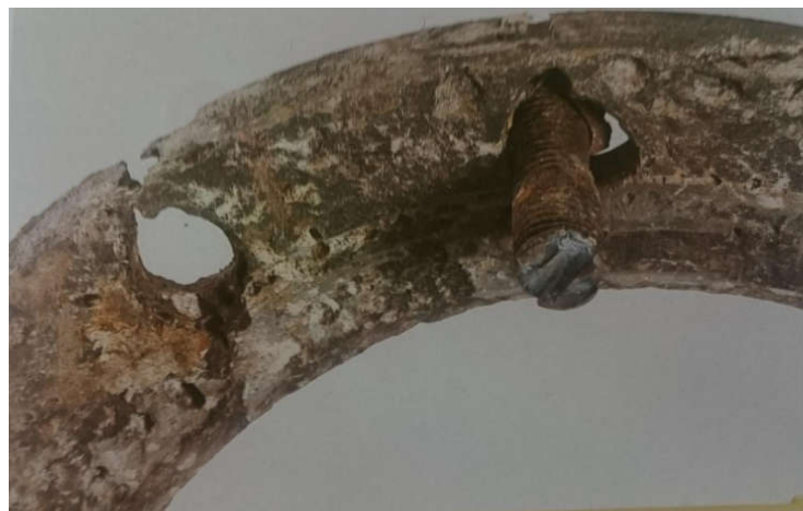
Slika 1.13. Galvanska korozija aluminijske legure 26
