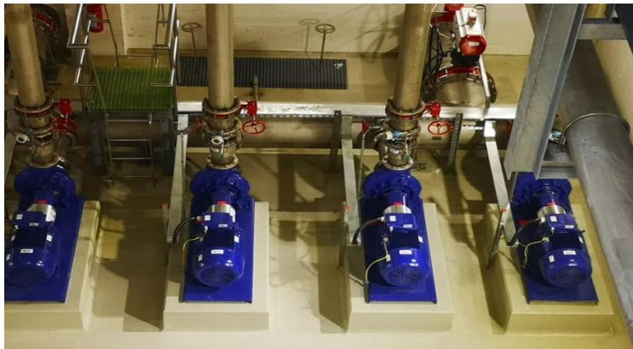
**Slika 27.** Centrifugalne crpke pomoću koji se voda odvodi na mehaničku filtraciju.
