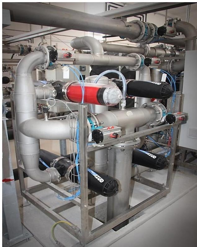
*Slika 29.* Sustav mehaničkih filtara tipa *AZUD-Spin Klin*.
