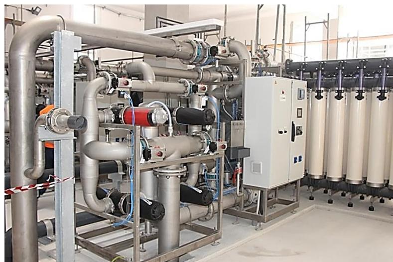
**Slika 28.** Sustav mehaničke filtracije i ultrafiltracije.
