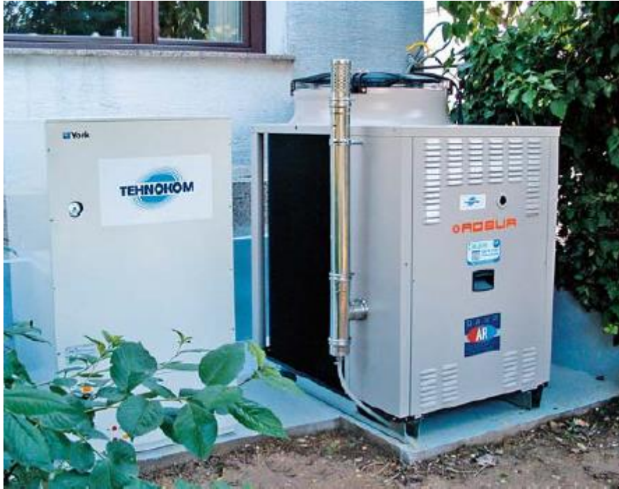
Slika 4.2 - Tehnokom-ova apsorpcijska plinska dizalica topline [8]
