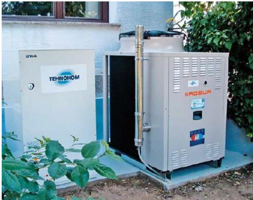
Slika 4.2 - Tehnokom-ova apsorpcijska plinska dizalica topline [8]
