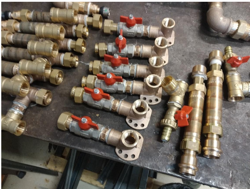
Slika 5.27 - Priprema sklopa izljevnikog mjesta
