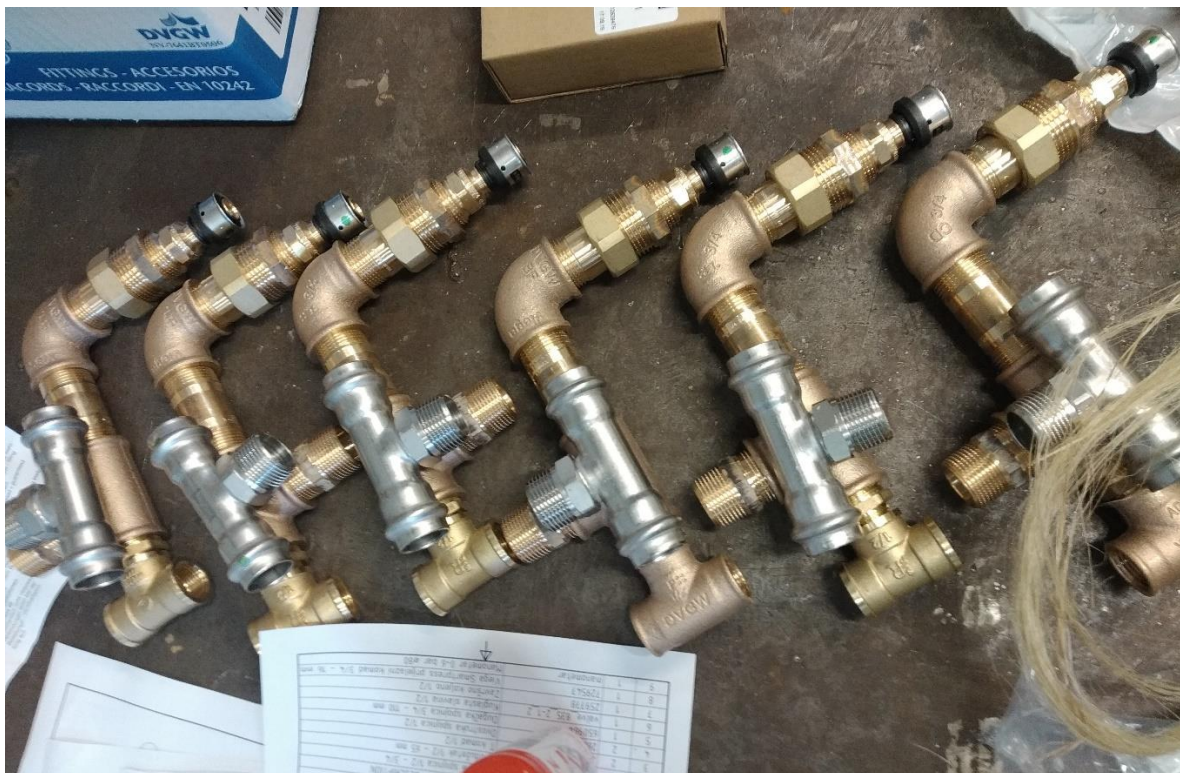
Slika 5.26 - Priprema sklopa prijelaza cjevovoda kroz ploču
