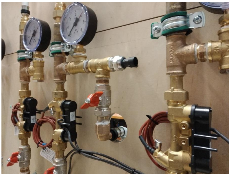
Slika 5.39 - Spoj presostata i rastezne posude na najudaljenije izljevno mjesto
