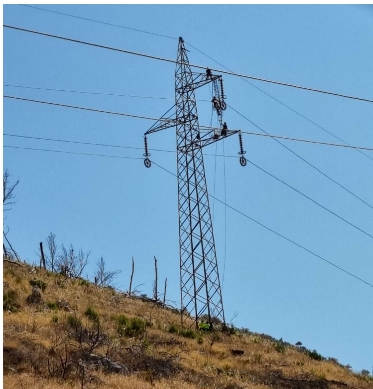
Slika 5.2. Armiranje nosivog stupa
