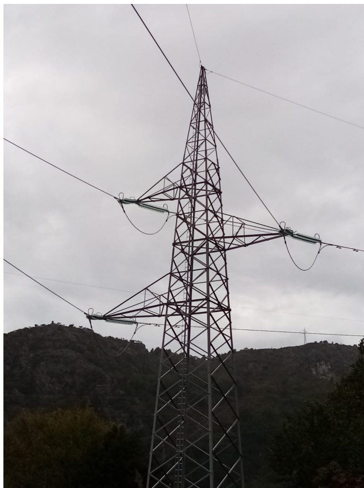
Slika 5.7. Zatezni stup nakon završene elektromontaže
