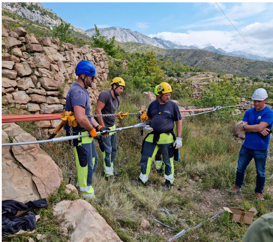
Slika 5.9. Izrada nastavne kompresijske spojnice vodiča
