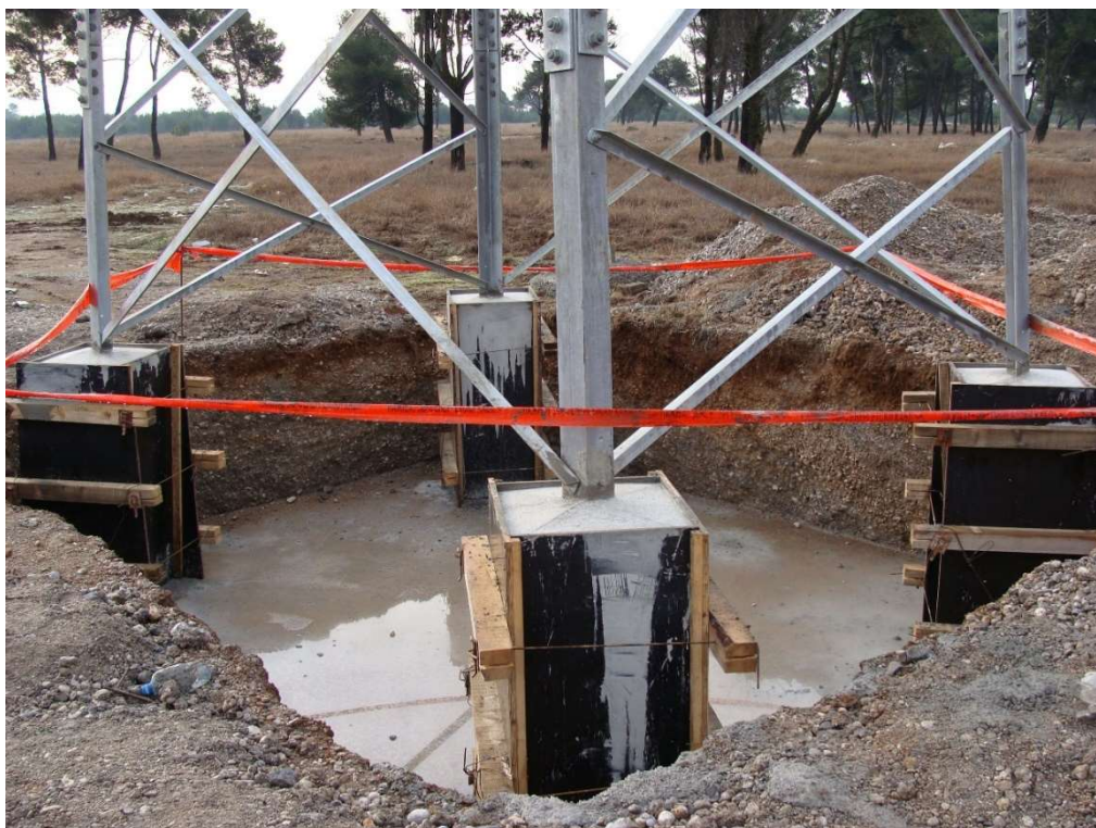
Slika 2.3. Temelj čelično-rešetkastog stupa
