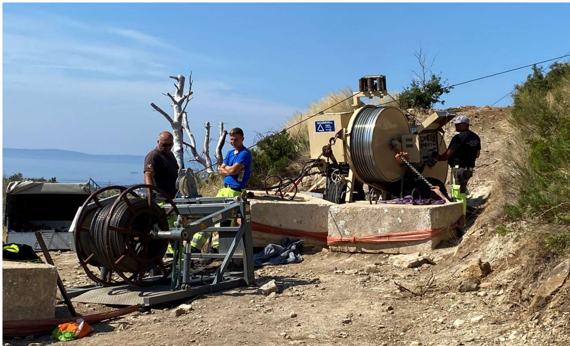
Slika 5.4. Stroj za razvlačenje vodiča, vučni stroj
