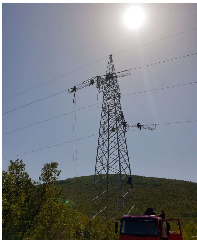
Slika 5.3. Armiranje zateznog stupa
