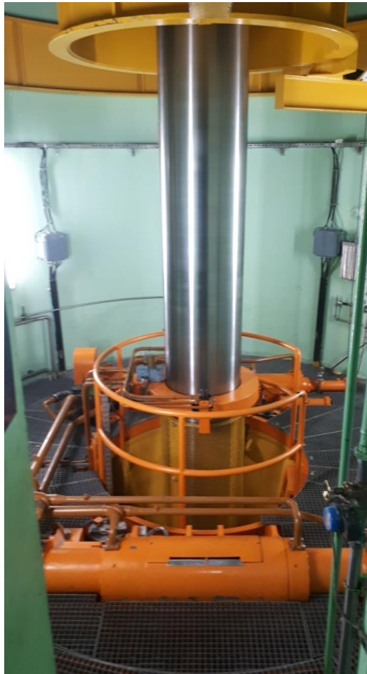
Slika 4. 22. Vratilo turbine [15]
