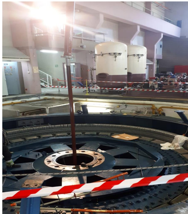
Slika 4. 10. Cijevi u vratilu [15]
