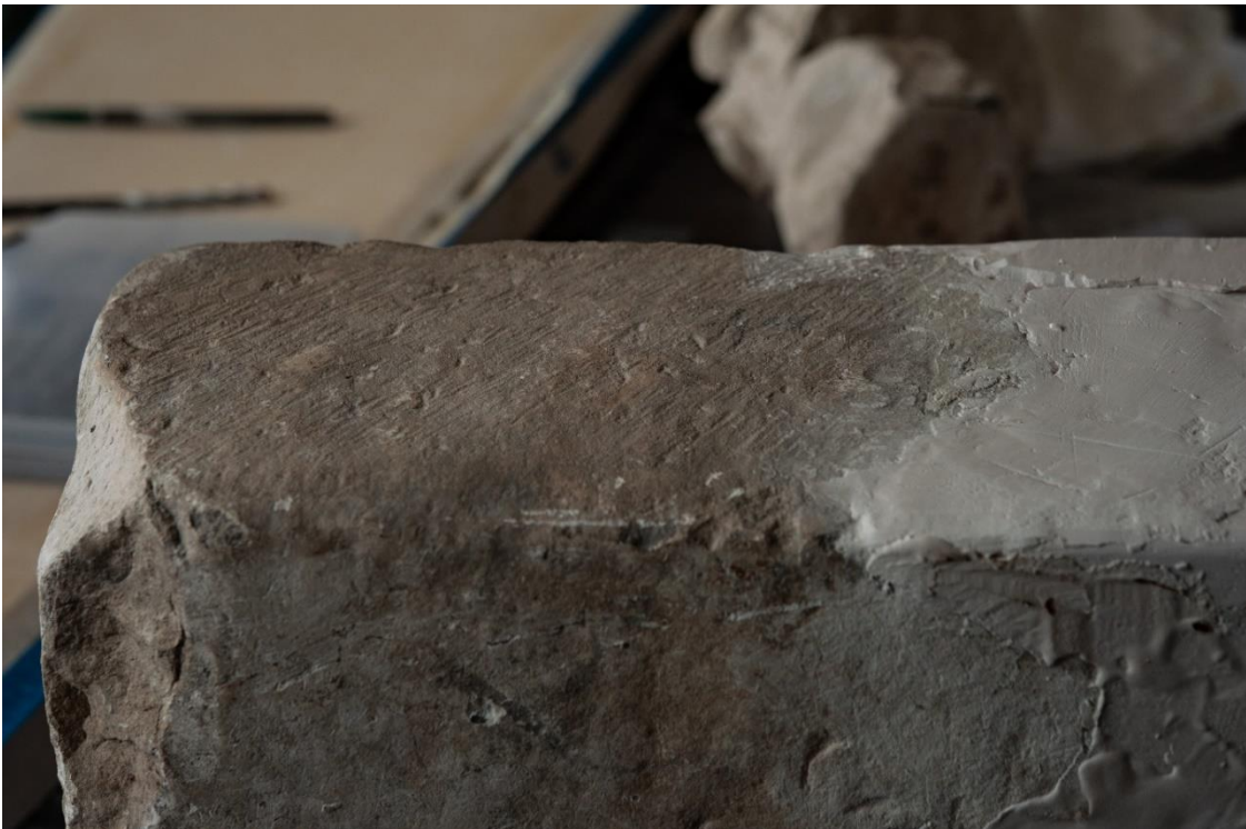
Slika 72 i Slika 73 Vidljivi tragovi dlijeta na originalnim ulomcima (autor: Rina Dubravec)
