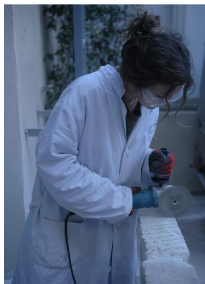
Slika 29 i Slika 30 Pilanje stare betonske rekonstrukcije (autor: Zoran Boban i Rina Dubravec)
