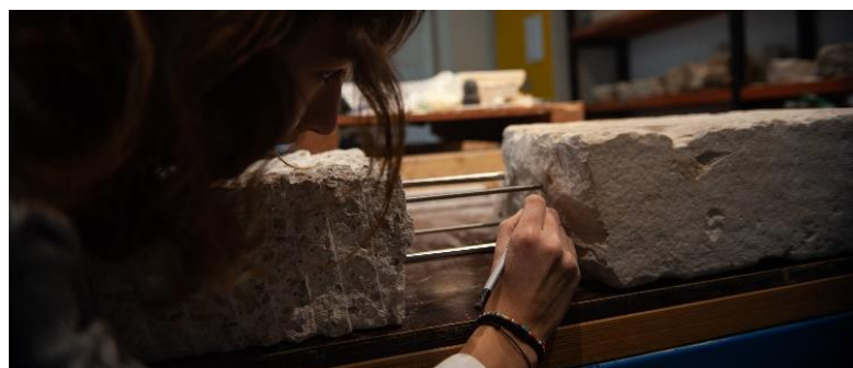
Slika 39 Označavanje olovkom predviđeno mjesto za bušenje novih rupa (autor: Mladen Matijaca)
