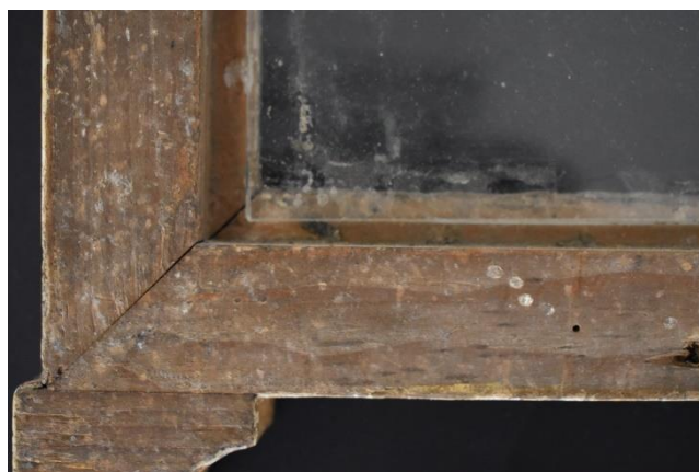
Slika 19 Drveni nosioc, detalj, površinska nečistoća
