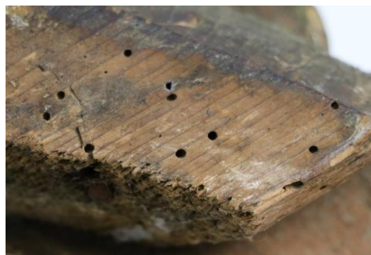
Slika 66 Rupice crvotočine na gornjoj konstruktivnoj letvici, detalj
