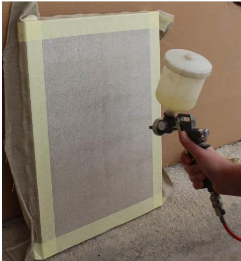
Slika 141 Nanošenje prvog sloja otopine Beva-e kompresorom preko cijelog platna
