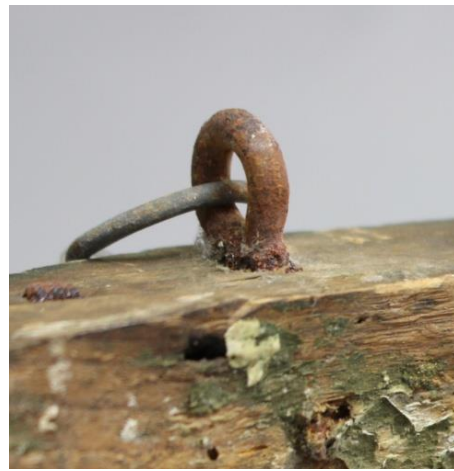
Slika 59 Korodirana kukica za vješanje, detalj
