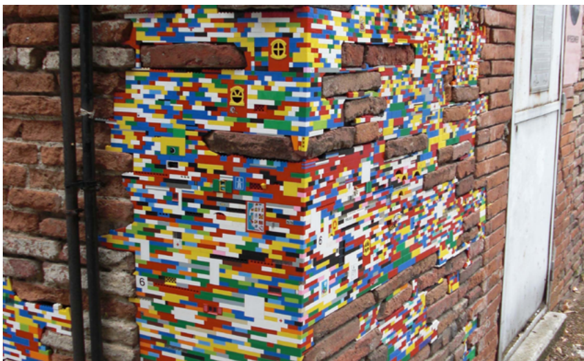
Slika 7. Dispatchwork – Popravljanje pukotina s Lego kockicama
