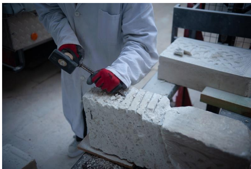
Slika 31 Uklanjanje sloja debljine 2 cm s stare rekonstrukcije (autor: Zoran Boban)
