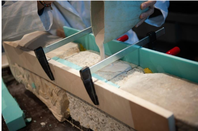
Slika 59 Lijevanje Acrystone smjese na vanjskoj bočnoj strani pilastra (autor: Rina Dubravec)
