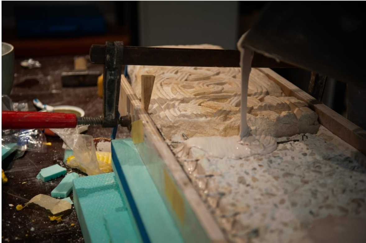
Slika 62 Lijevanje Acrytalne smjese na lice pilastra (autor: Rina Dubravec)
